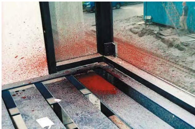
Figure 4: Flaque de sang due à un goutte à goutte prolongé.
